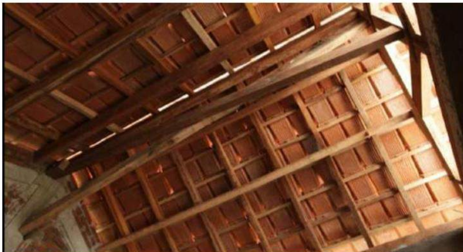
Gambar II.395 Ikatan Angin Antara Kuda-Kuda Kayu dengan Gunung-Gunung/ Ampig
