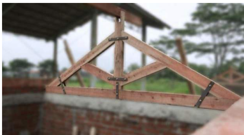
Gambar II.387 Kuda-kuda Kayu Dengan Pengikat Plat Baja
