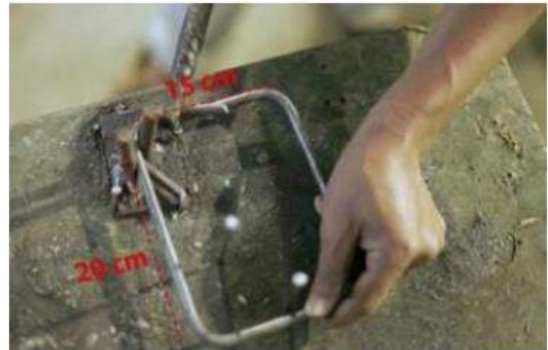
Gambar II.382 Tekukan Ujung Tulangan Begel
