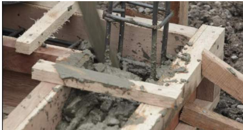
Gambar II.418 Pengecoran Balok Pengikat/ Sloof
