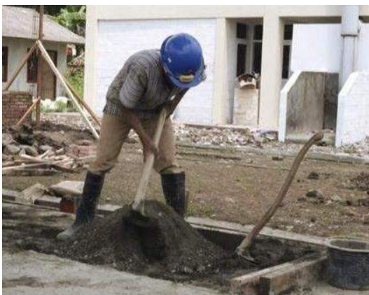
Gambar II.367 Proses Pencampuran Mortar
