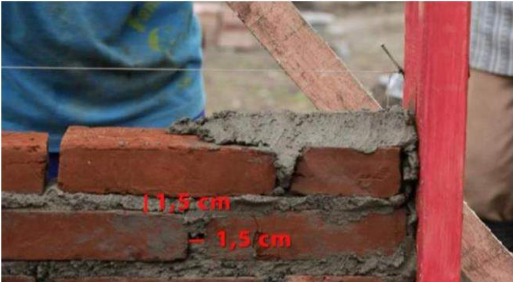
Gambar II.400 Proses Pemasangan Batu Bata Untuk Dinding
