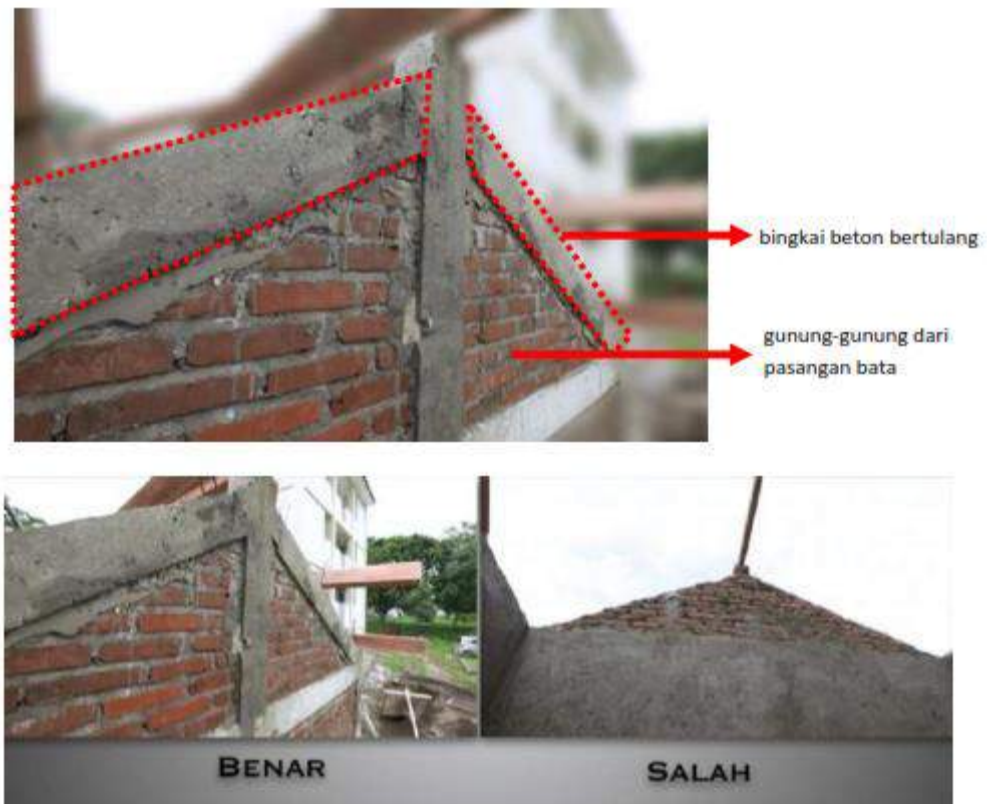
Gambar II.391 Gunung-Gunung/ Ampig
