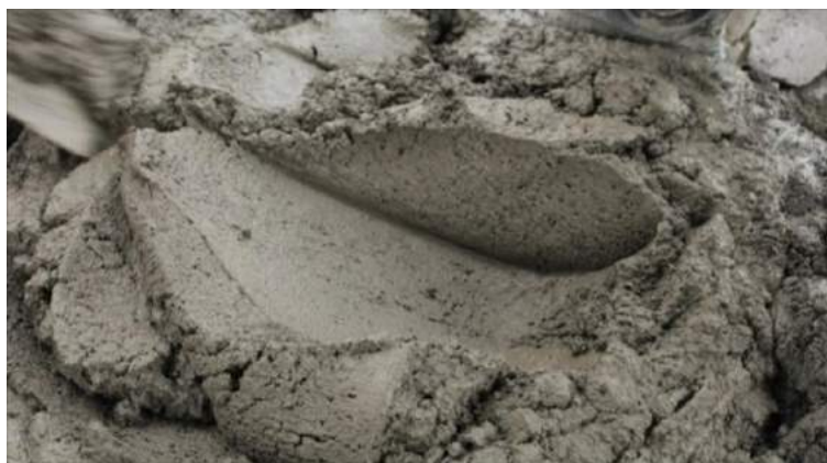
Gambar II.368 Hasil Pencampuran Mortar Yang Baik
