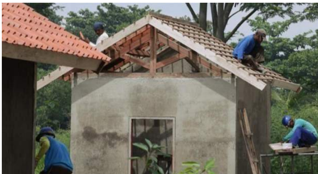
Gambar II.386 Kuda-kuda Kayu Pada Atap Rumah Tinggal
