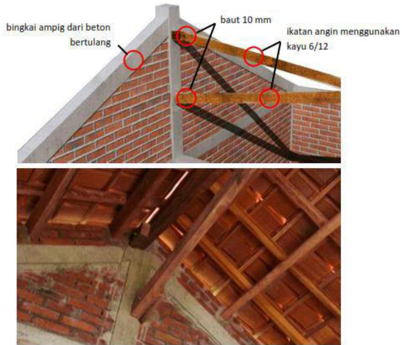
Gambar II.396 Pertemuan Antara Ikatan dengan Gunung-Gunung/ Ampig
