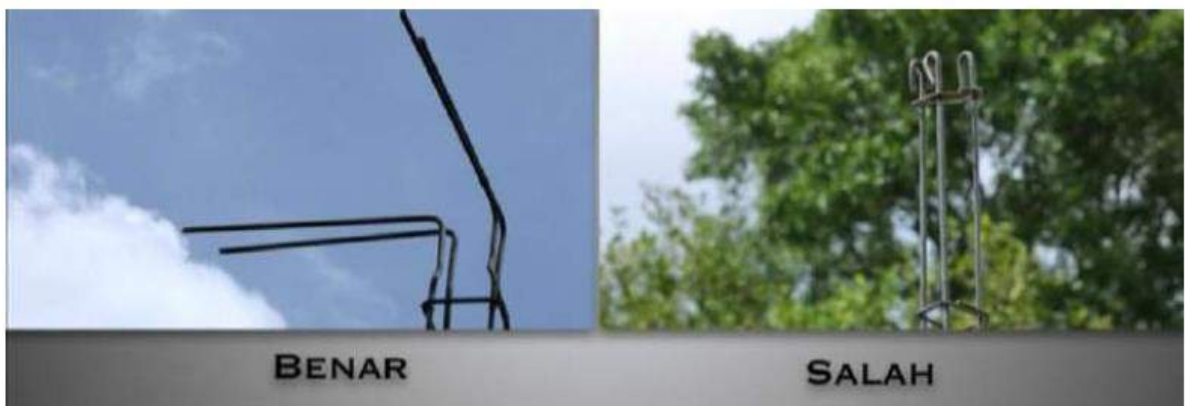
Gambar II.408 Tulangan Kolom Yang Akan Dibengkokkan Ke Dalam Balok Keliling/ Ring
