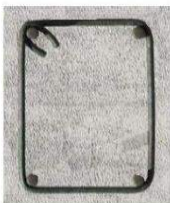
Gambar II.392 Tulangan Pada Bingkai Gunung-Gunung/ Ampig
