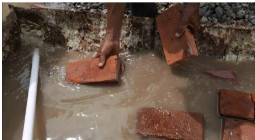
Gambar II.374 Perendaman Batu Bata Sebelum Dipasang
