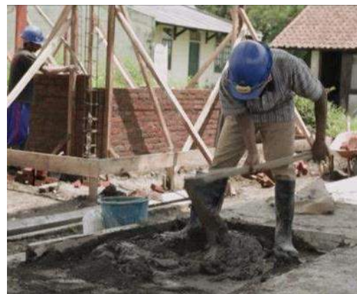
Gambar II.367 Proses Pencampuran Mortar
