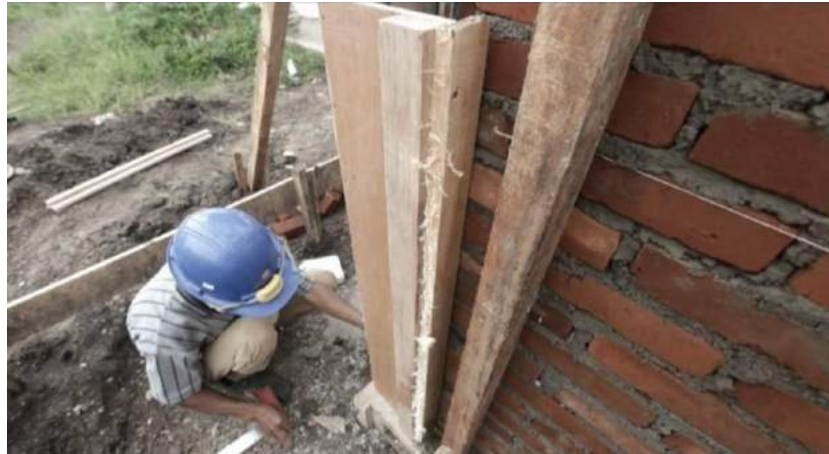
Gambar II.414 Pemasangan Cetakan/ Bekisting Untuk Kolom
