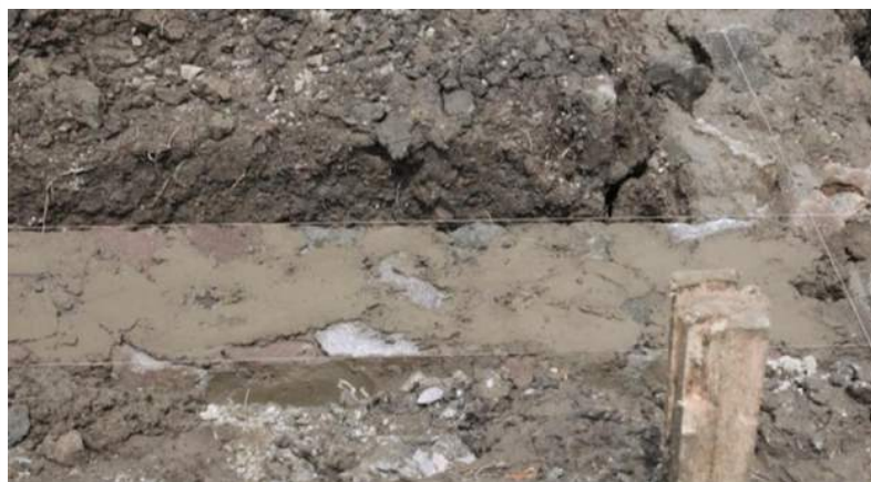
Gambar II.370 Pondasi Dari Batu Kali/Gunung
